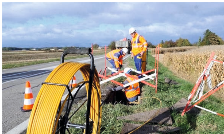
Le chantier de déploiement de la fibre avance à grand pas... (Document Rosace)
