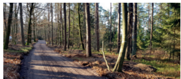
Les chemins d'exploitation nécessaires à la construction du chemin des cimes ont été réalisés par l'Entr. Jean-Luc Ruffy
