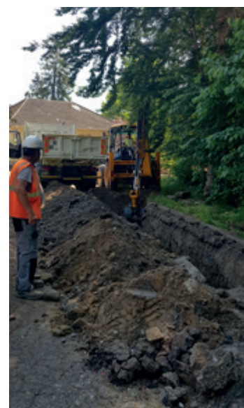
Pose du câble électrique
