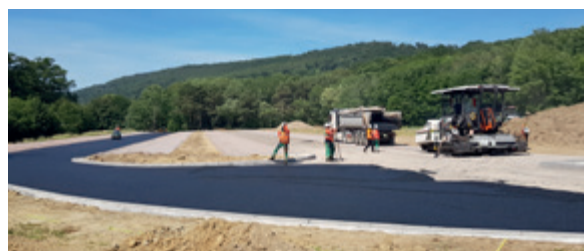
Vue de la deuxième rangée de parkings
