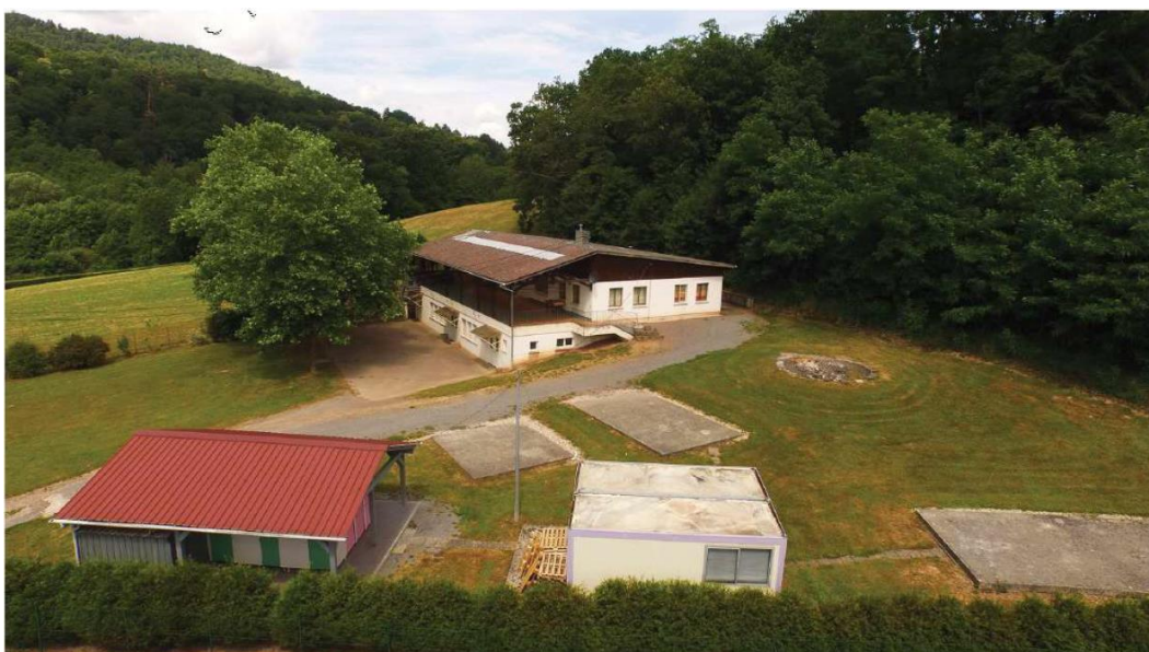
Etat actuel des bâtiments du Chalet Rossignol qui seront remplacés par le centre de vacances adapté
