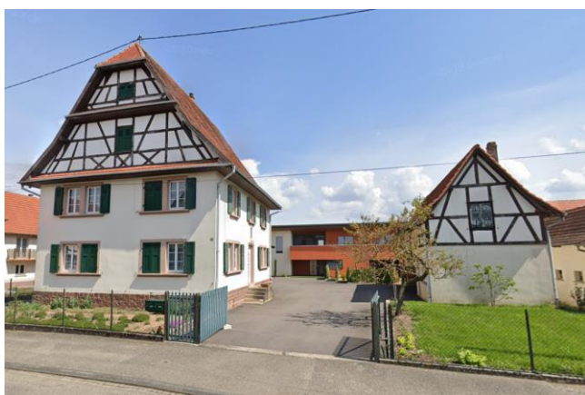
Exemple de grange réhabilitée en fond de cour avec suppression du toit en pente
