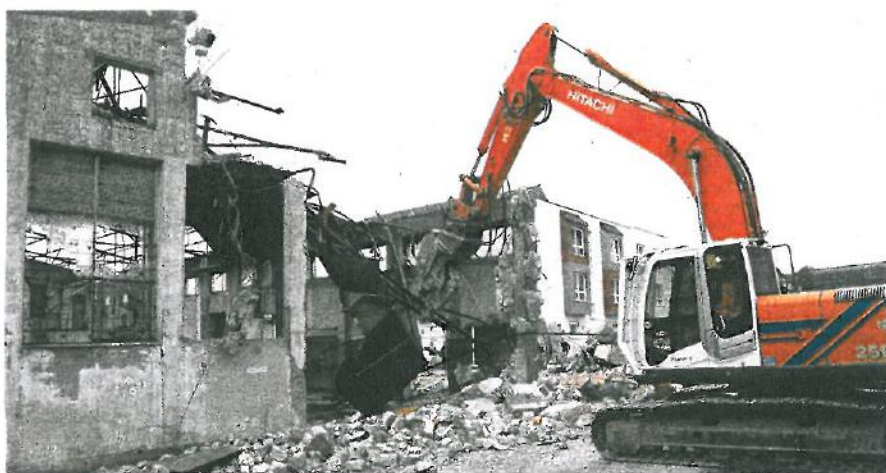
En manque de logements pour les ménages actifs, la Ville de Wissembourg a lancé plusieurs programmes immobiliers. 35 logements sortiront notamment de terre en 2014 sur l'ancien site Gummi-Mayer. PHOTO ARCHIVES DNA
