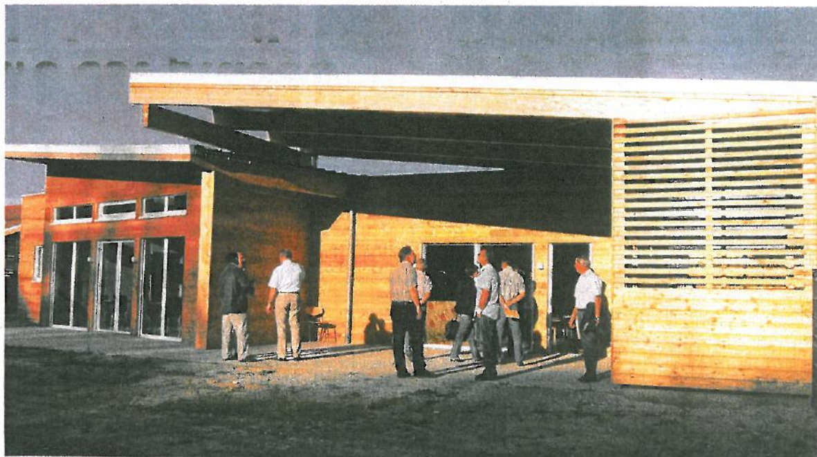
Le bâtiment de 330 mètres carrés est la troisième structure de ce type sur le territoire de la communauté de communes du Pays de Wissembourg, après Seebach et Wissembourg. PHOTOS DNA - MA.DA
